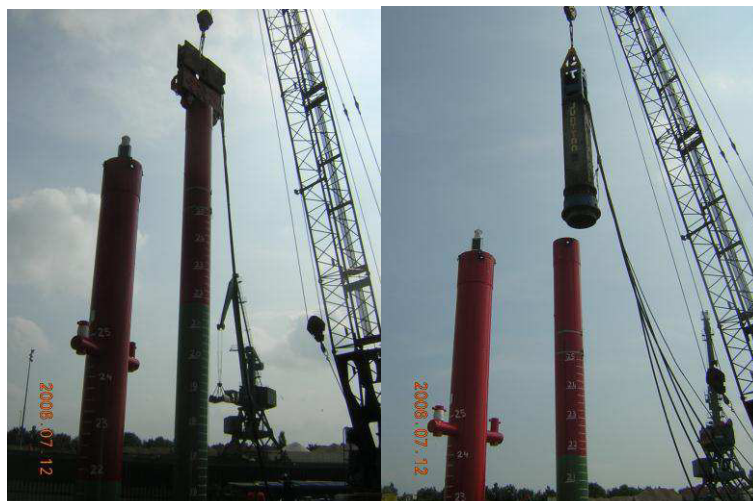
Bilder 5a und 5b : Vibrieren und Rammen
